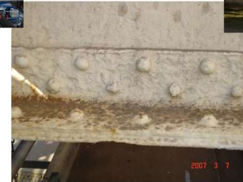
激しく腐食した床桁
