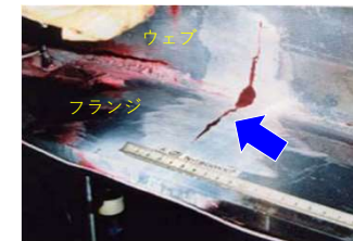
フランジ・ウェブ間隅内溶接部から発生した疲労き裂
