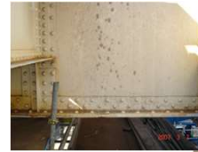
激しく腐食した床桁
