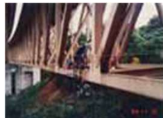
上路トラス橋外観
