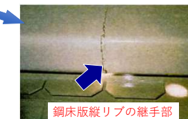
鋼床版縦リブの継手部
