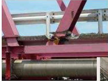
斜材の破断
