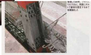
補修後の状況
