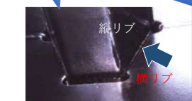
鋼床版縦リブと横リブ交差部の継手部
