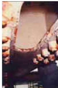
下弦材高力ボルト継手
