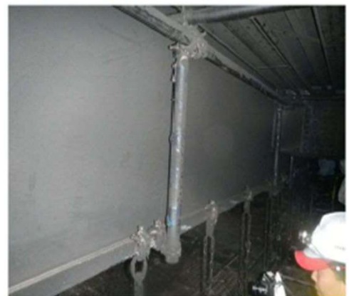
【④上り 足場内】 撮影日：3/20
