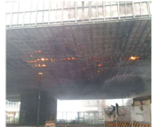
【②下り線 足場下】 撮影日：3/20
