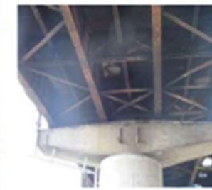
写真7 足場の撤去完了状況
