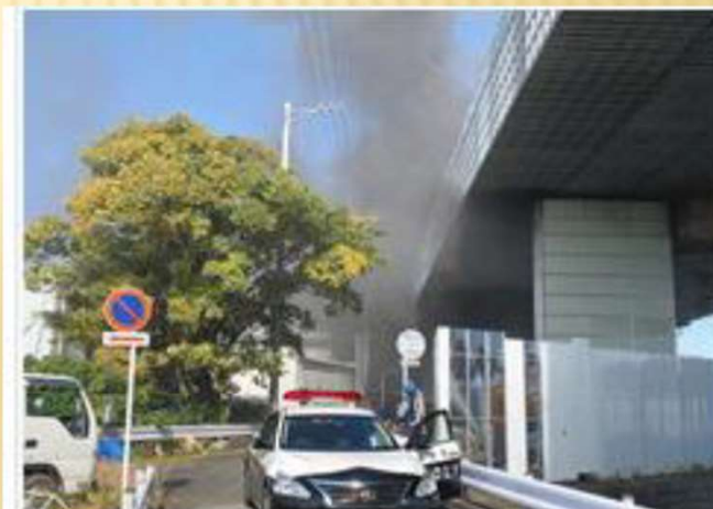
黒煙を上げて燃える東名高速道路の火災 現場 = 21日、静岡市駿河区中吉田で (読者提供)
