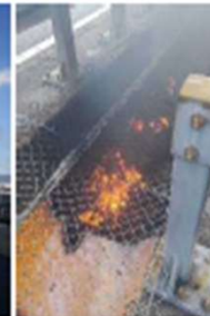
写真2 火災状況 [本線から]
