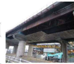
写真6 足場の撤去状況
