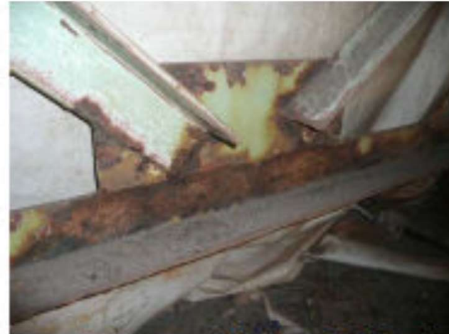
3種ケレン(動力工具処理)
