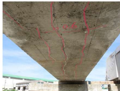
写真-2 劣化試験PC桁の状況写真
