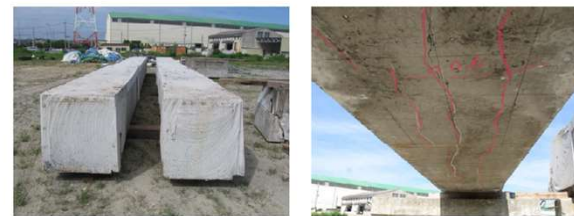
写真-2 劣化試験PC桁の状況写真
