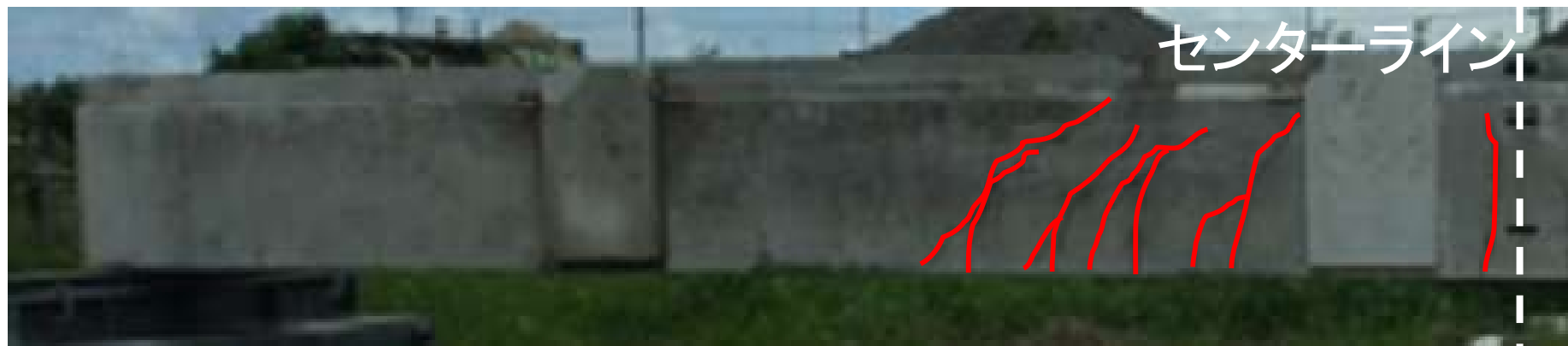
図-21 曲げ破壊荷重でのひび割れ図（実験）
