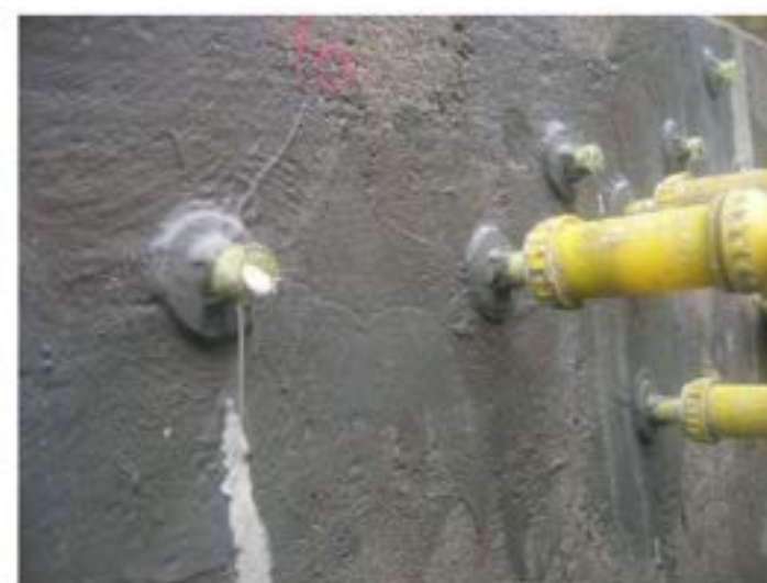
写真 4-5 超微粒子セメント系ひび割れ注入材本注入の施工状況
