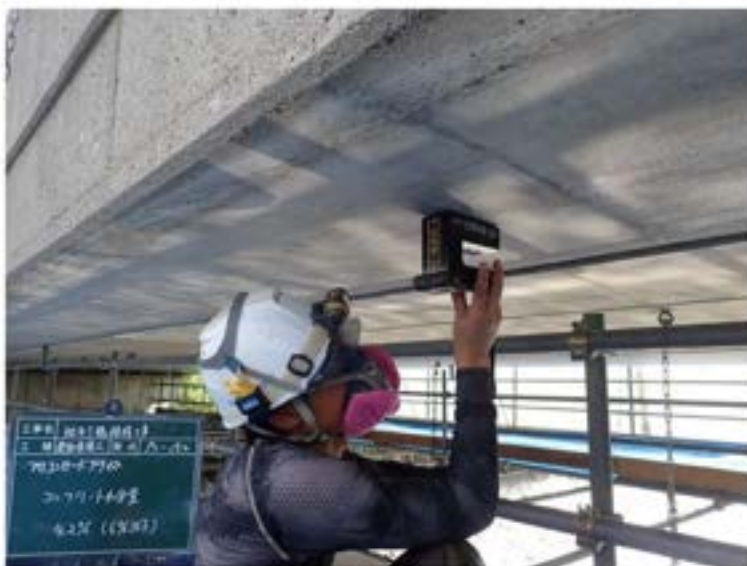
写真 4-3 コンクリート表面水分率の測定状況
