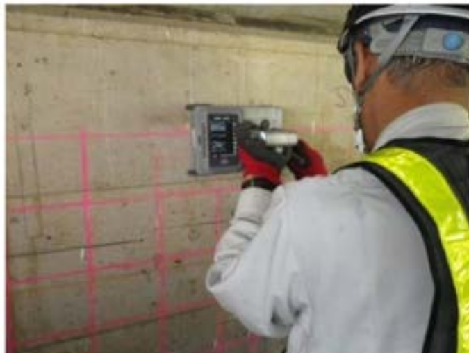
写真 4-4 鉄筋探査状況
