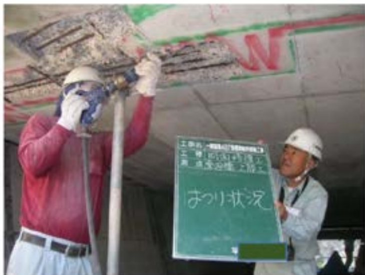
写真 4-1 人力によるはつり作業状況
