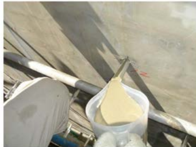
写真 4-7 圧入孔充填状況
