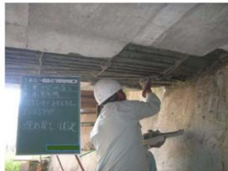
写真 4-5 断面修復状況
