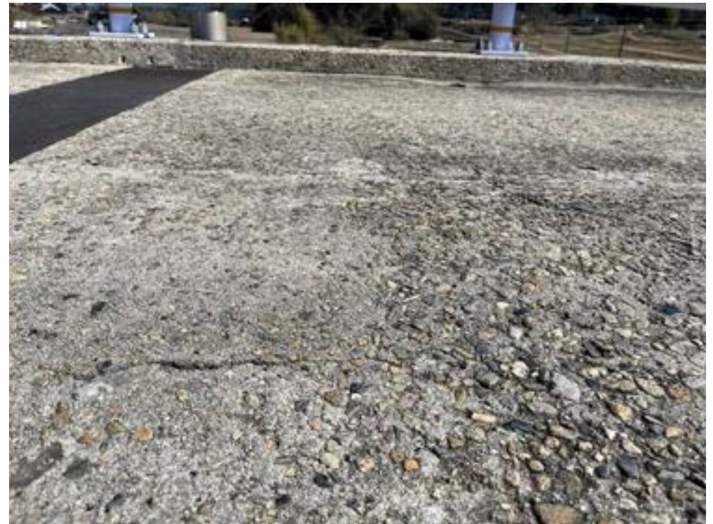
亜硝酸リチウム塗布後の状況
