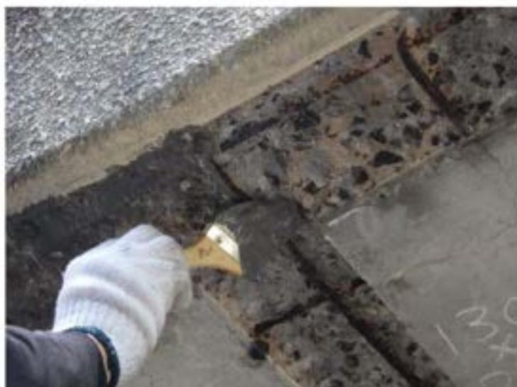
写真 4-4 鉄筋防錆処理状況
