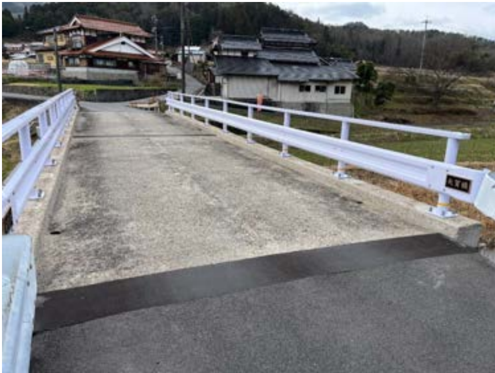
亜硝酸リチウム塗布後の状況
