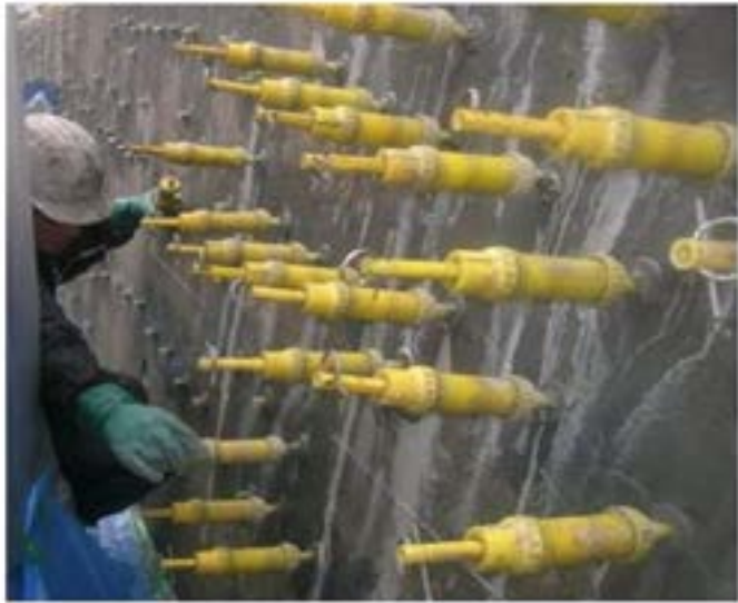
写真 4-1 表面漏出防止工(ひび割れ注入工)
