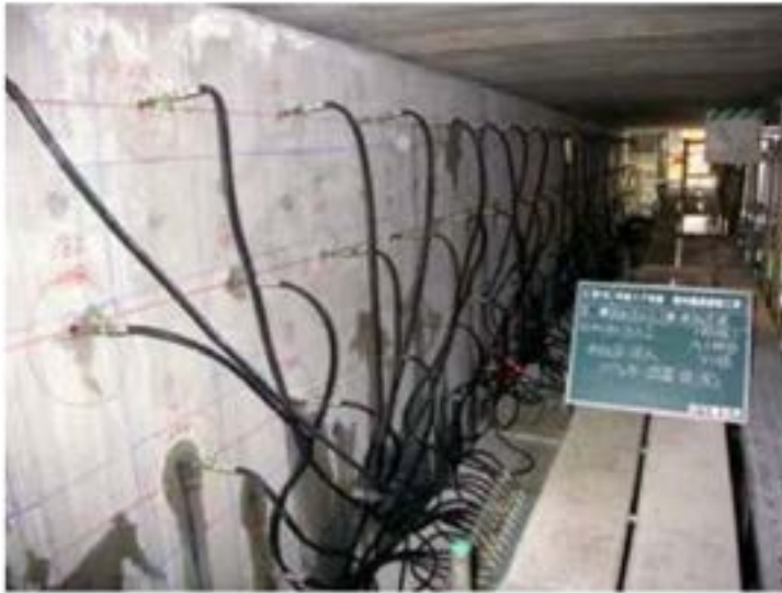
写真 4-6 加圧パッカー装着及び配管状況
