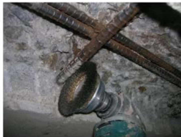
写真 4-3 鉄筋ケレン状況
