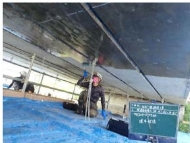
写真 4-2 亜硝酸リチウム系表面含浸材塗布工の施工状況
