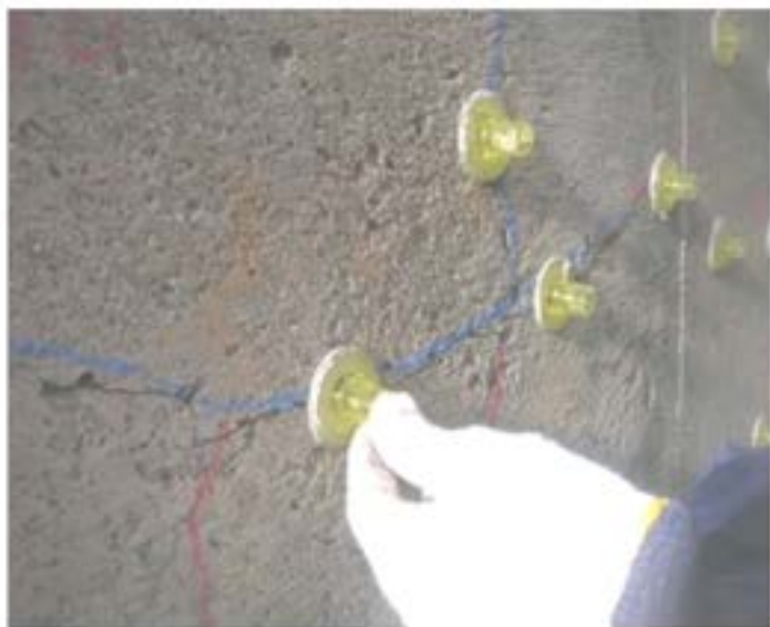
写真 4-2 座金取り付け工の施工状況
