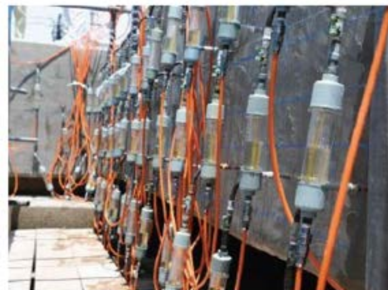
写真 4-6 リハビリカプセル設置状況
