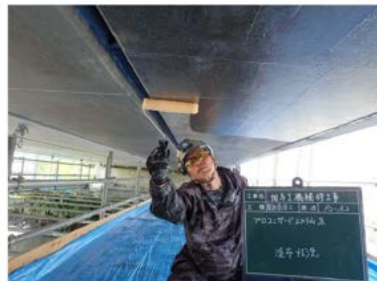
写真 4-4 シラン・シロキサン系表面含浸材塗布工の施工状況
