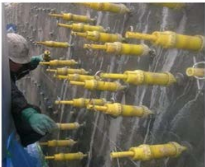
写真 4-1 表面漏出防止工(ひび割れ注入工)
