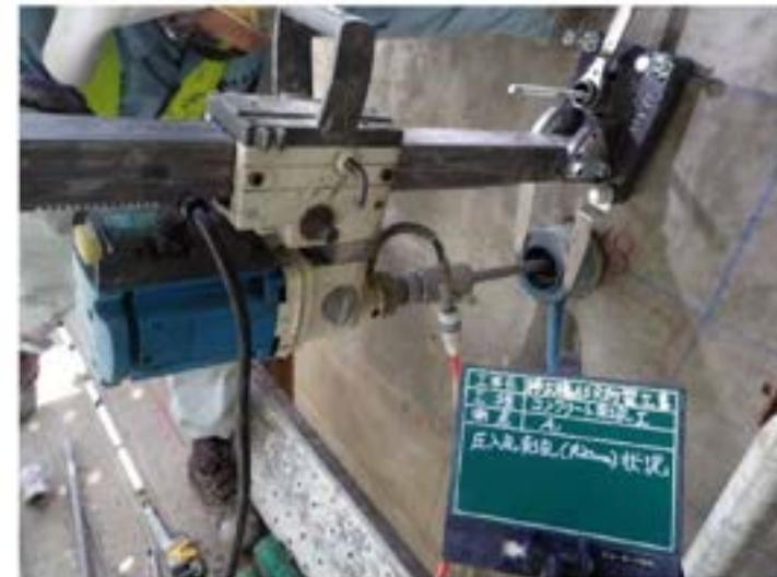
写真 4-5 削孔状況(ダイヤモンドコアドリル)
