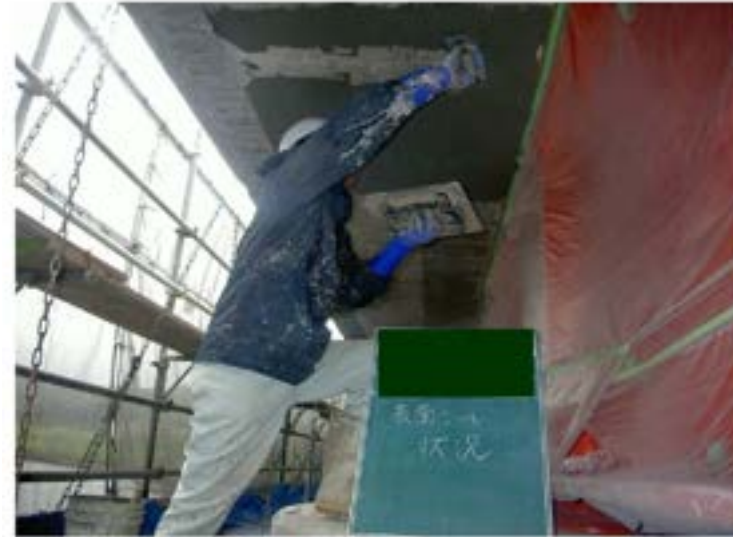
写真 4-2 表面漏出防止工(表面シール工)
