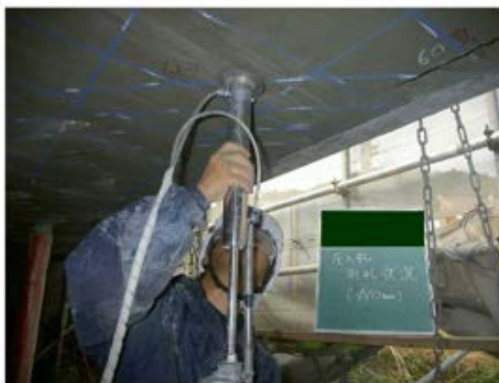
写真 4-5 削孔状況(ダイヤモンドコアドリル)
