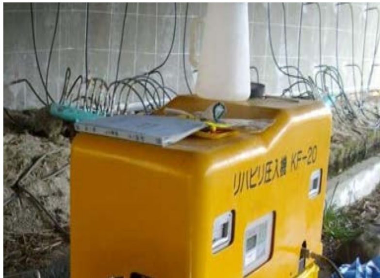
写真 4-6 加圧パッカー装着及び配管状況
