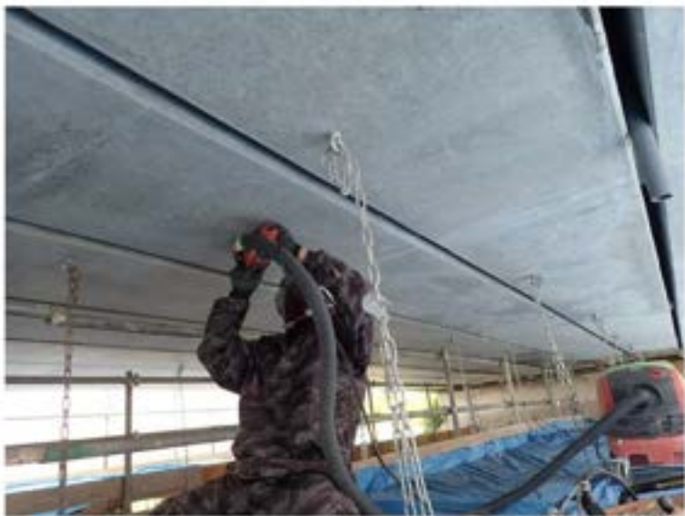
写真 4-1 下地処理工の施工状況
