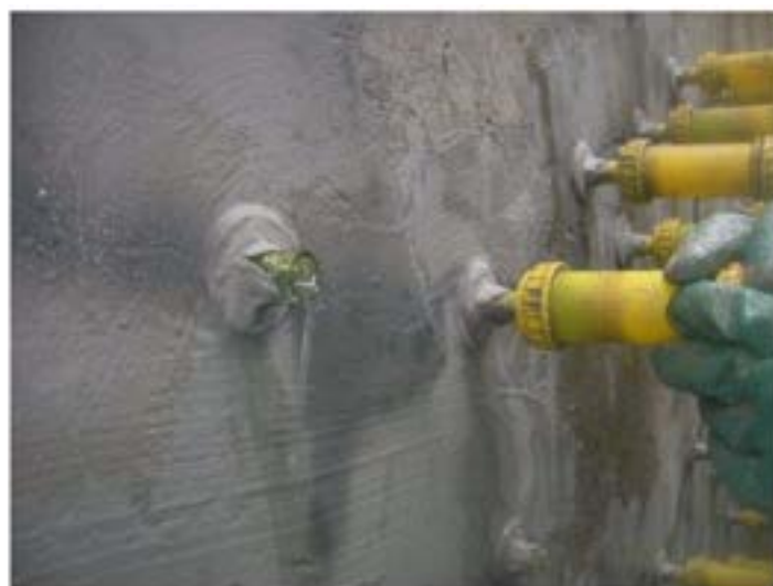
写真 4-4 浸透拡散型亜硝酸リチウム先行注入の施工状況
