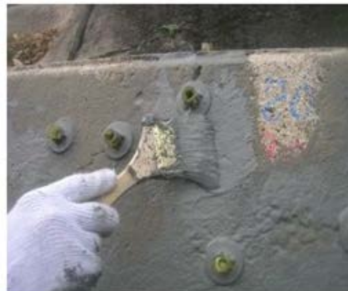
写真 4-3 ひび割れシール工の施工状況
