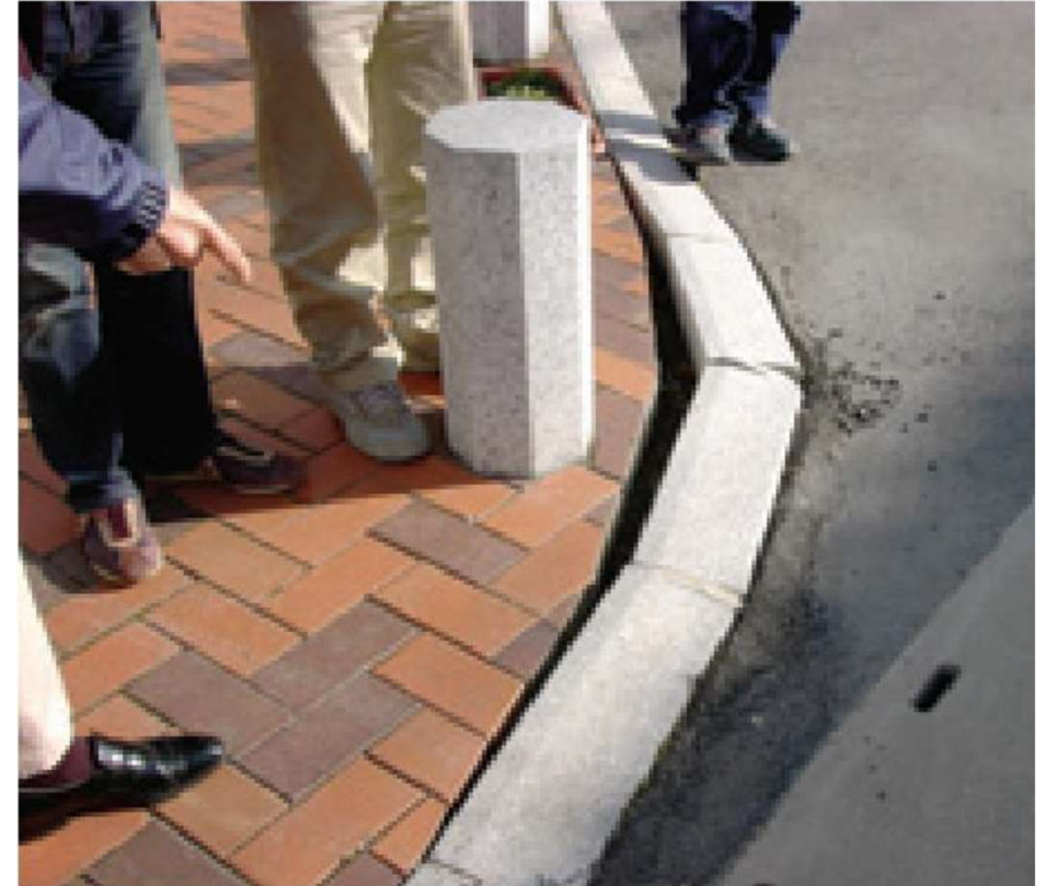
縁石ブロックのDEF膨張(九州北部)
