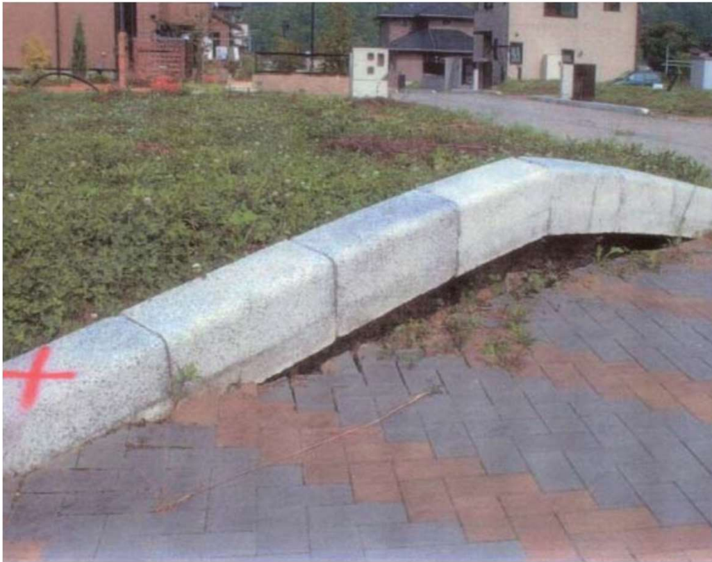
縁石ブロックのDEF膨張(九州北部)
