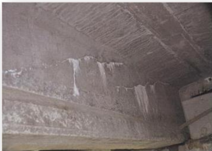
グラウト充填不良により生じたPC鋼材に沿ったひび割れとエフロレッセンス
