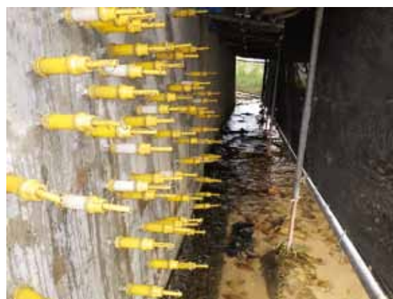
亜硝酸リチウム先行注入状況
