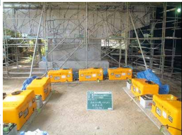
図 3-32 内部圧入工法の施工状況
