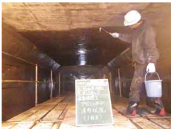
プロコンガード塗布状況
