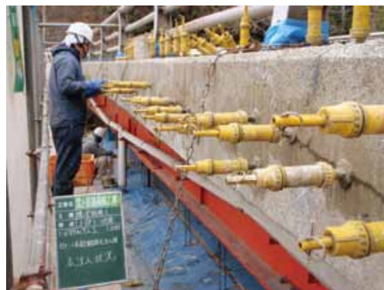
無機系注入材本注入状況
