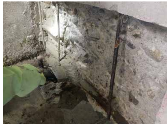
プロコンガードプライマー塗布状況
