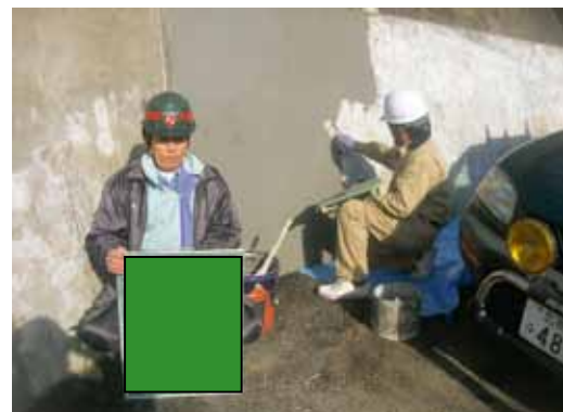
図 3-28 表面被覆工法の施工状況
