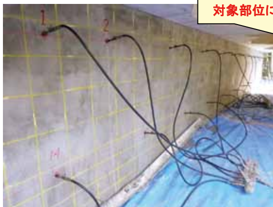
たて壁部施工状況：ASRリチウム工法
