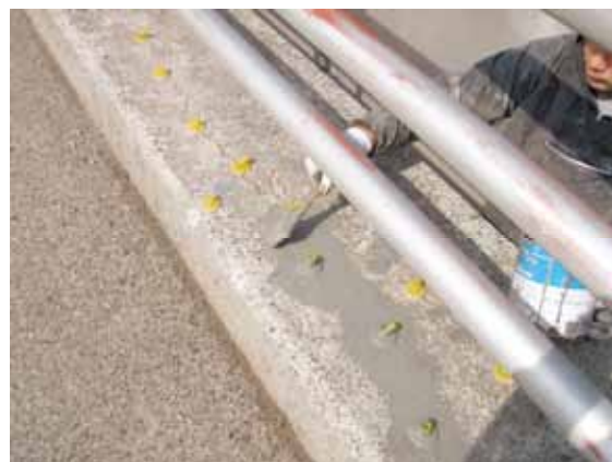
ひび割れシール状況
