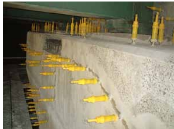
図 3-17 ひび割れ注入工法の施工状況
