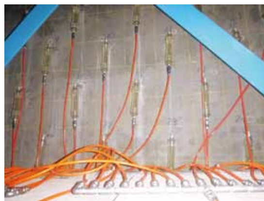
図 3-34 内部圧入工法の施工状況
