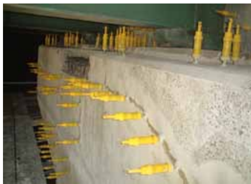
図 2-9 ひび割れ注入工法
