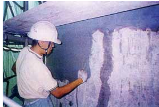
図 3-15 表面被覆工法の施工状況
