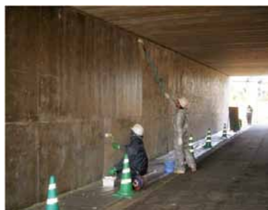
図 3-13 表面含浸工法の施工状況
