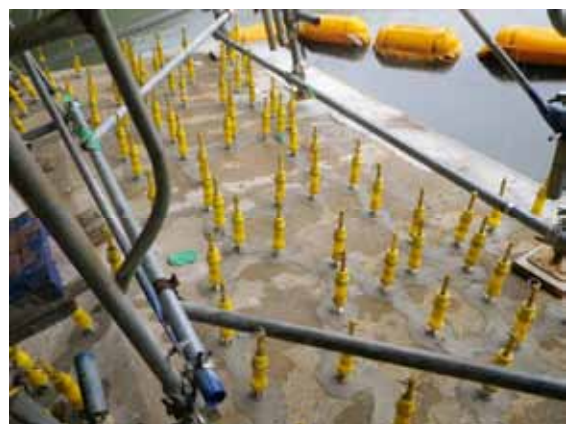
ひび割れ注入状況
