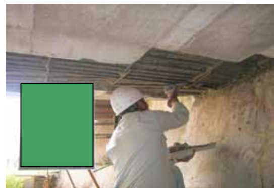
図 3-22 断面修復工法の施工状況
