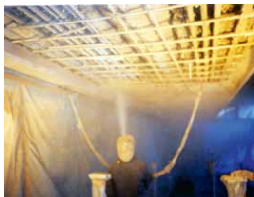
図 2-14 断面修復工法(吹付け工法)
