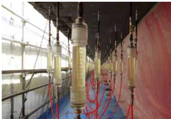
内部圧入工施工状況
