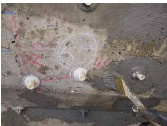
ひび割れシール塗布状況
