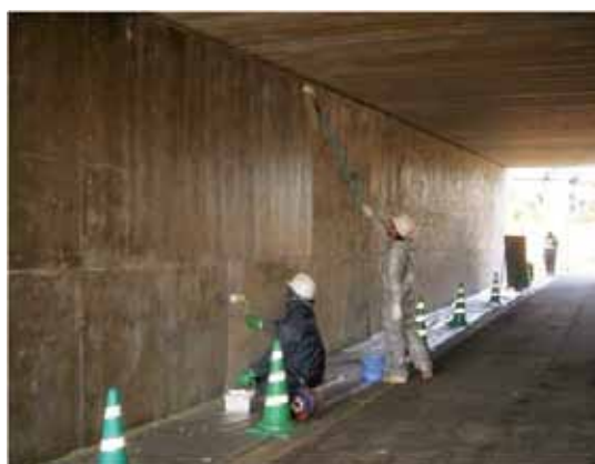
図 3-26 表面含浸工法の施工状況
