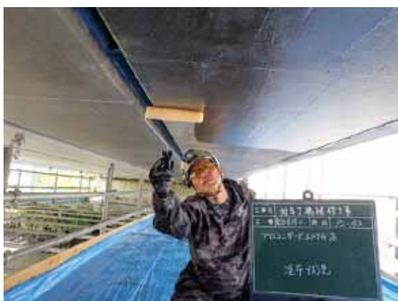
プロコンガード S 塗布状況
