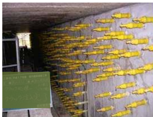
図 2-40 ひび割れ注入工
