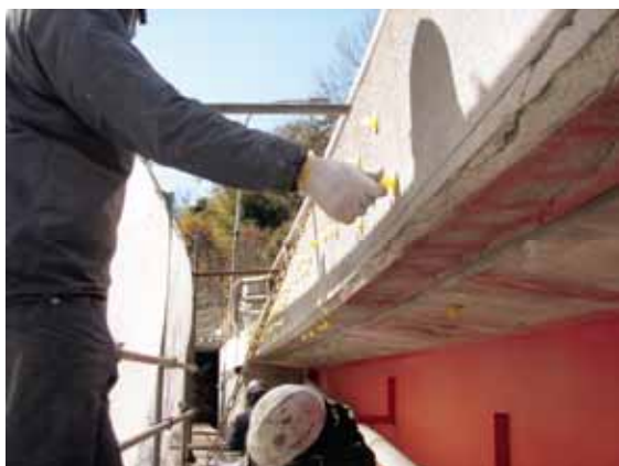
座金取付状況
