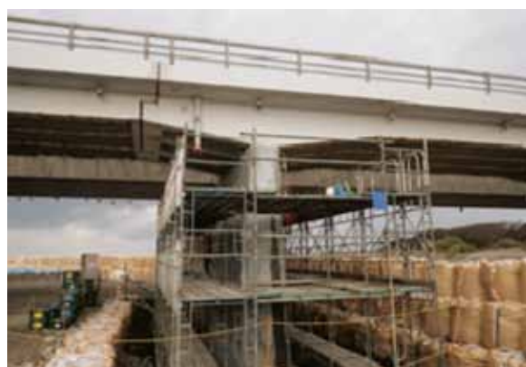
足場設置状況
