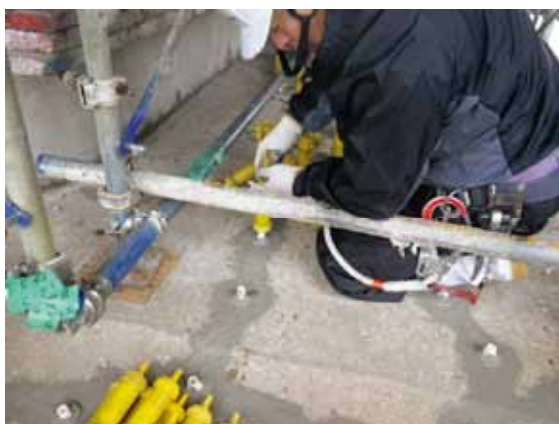
ひび割れ注入状況
