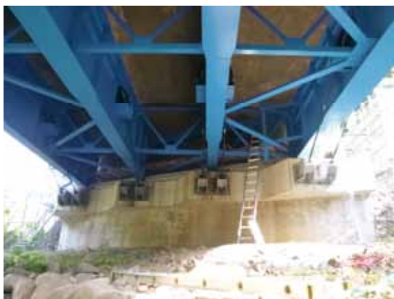
対象橋台全景
