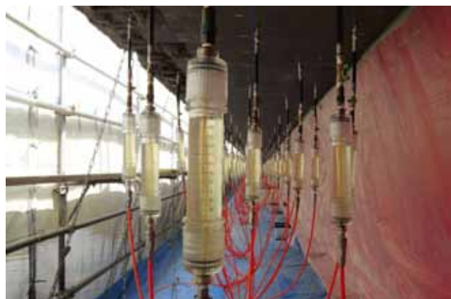
図 3-19 内部圧入工法の施工状況
