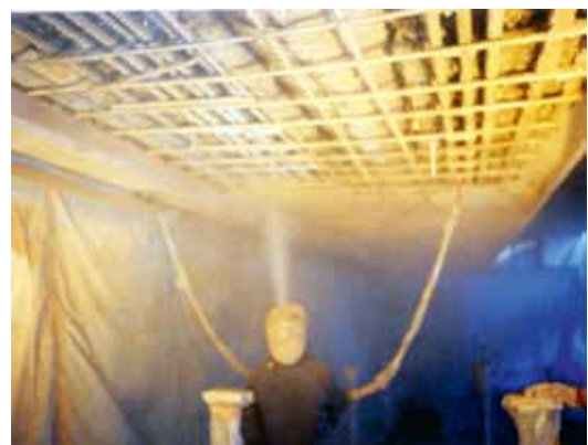
図 2-26 断面修復工法(吹付け工法)
