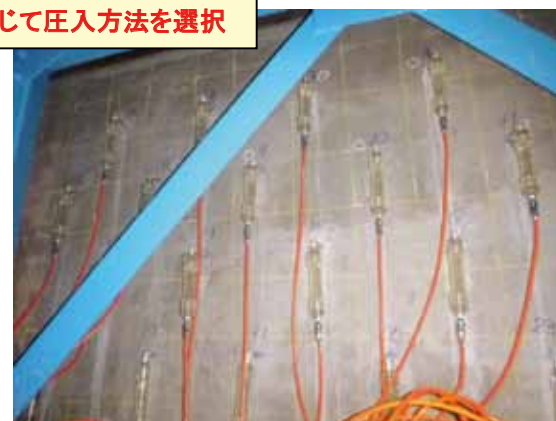
パラペット部施工状況：リハビリカプセル工法
