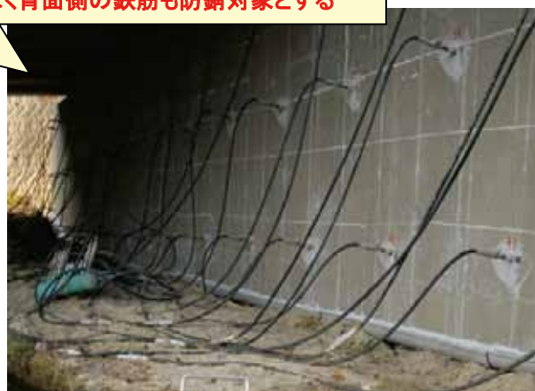
内部圧入工施工状況
