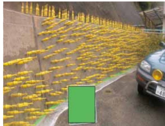
図 3-30 ひび割れ注入工法の施工状況
