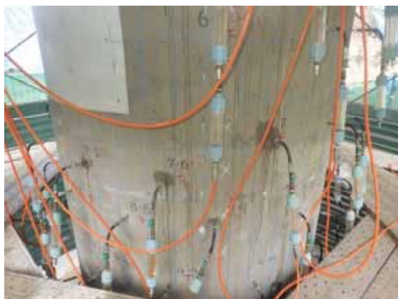
内部圧入状況
