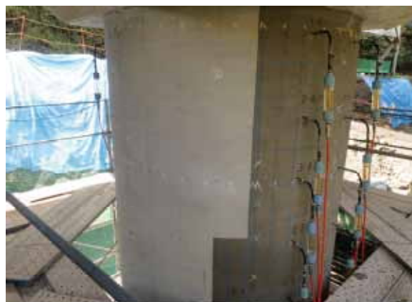
内部圧入状況
