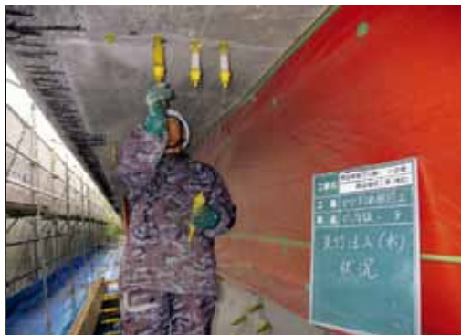
図 2-21 ひび割れ注入工法
