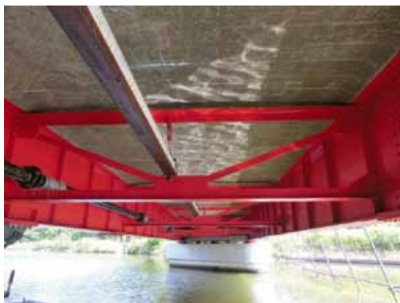
施工対象 RC 床版
