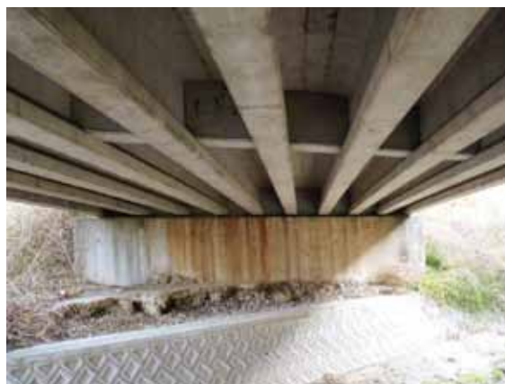
施工前状況（A2 橋台）
