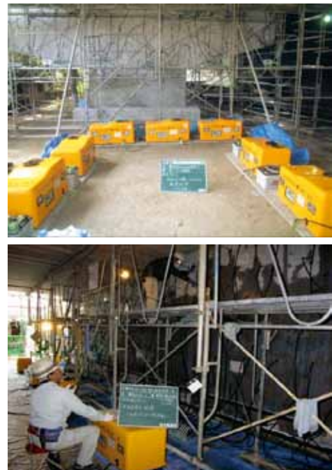
図 2-42 内部圧入工の施工状況
