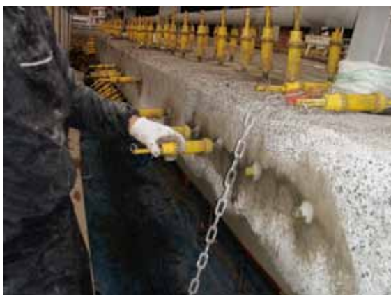
亜硝酸リチウム先行注入状況
