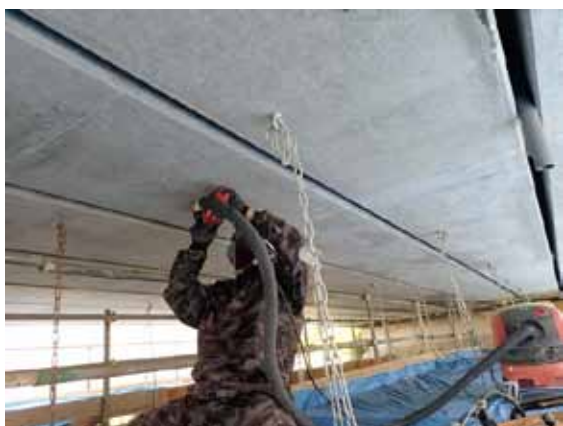
下地処理状況
