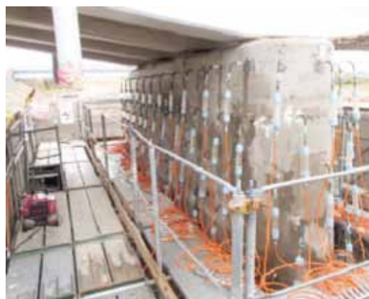
内部圧入状況
