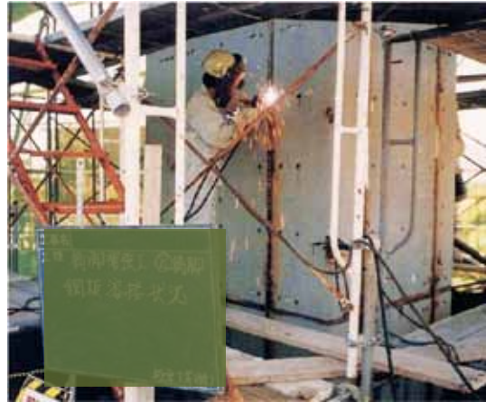
図 2-43 鋼板巻き立てによる膨張拘束
