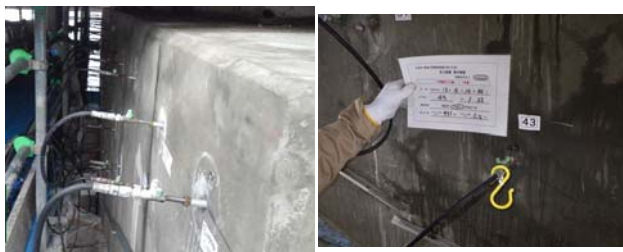
⑦ 試験加圧注入工
