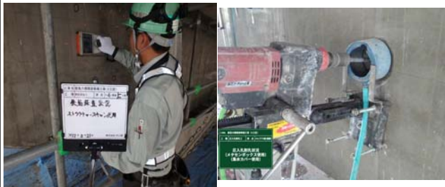
③ 鉄筋探査工
