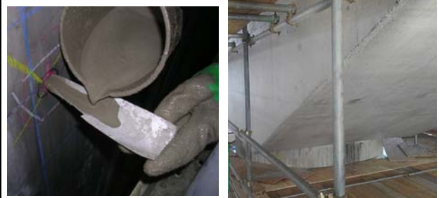
⑨ 圧入孔充填工
