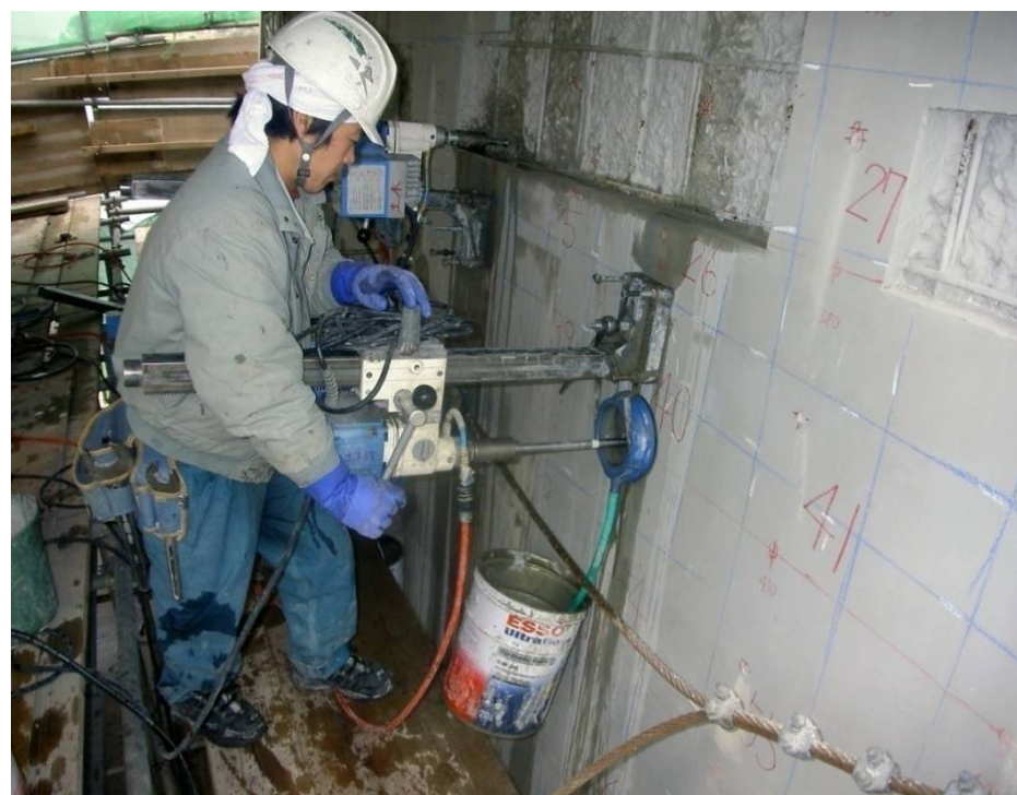
④圧入孔削孔
