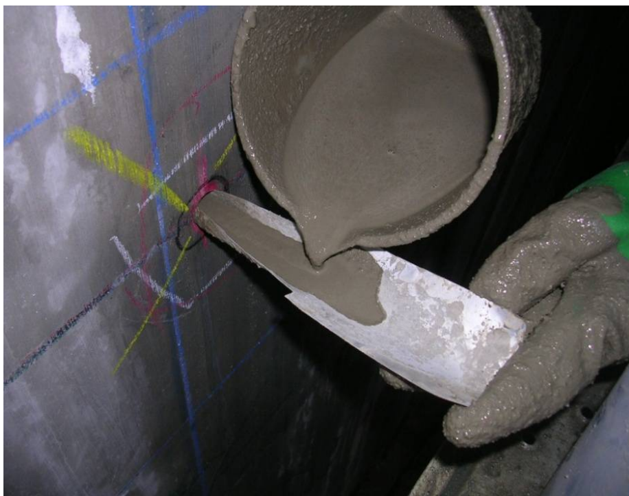
⑨ 圧入孔充填工
