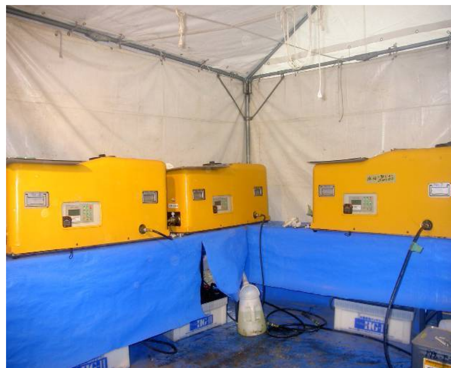
⑥圧入装置の設置
