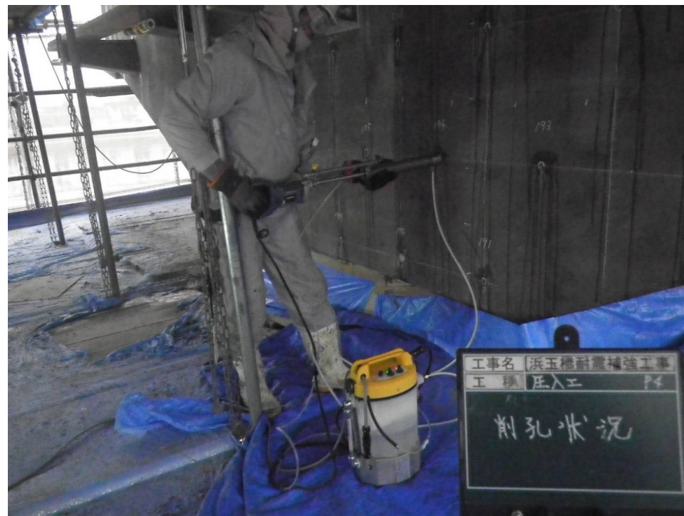
④圧入孔削孔
