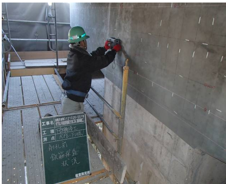
③鉄筋探査工
