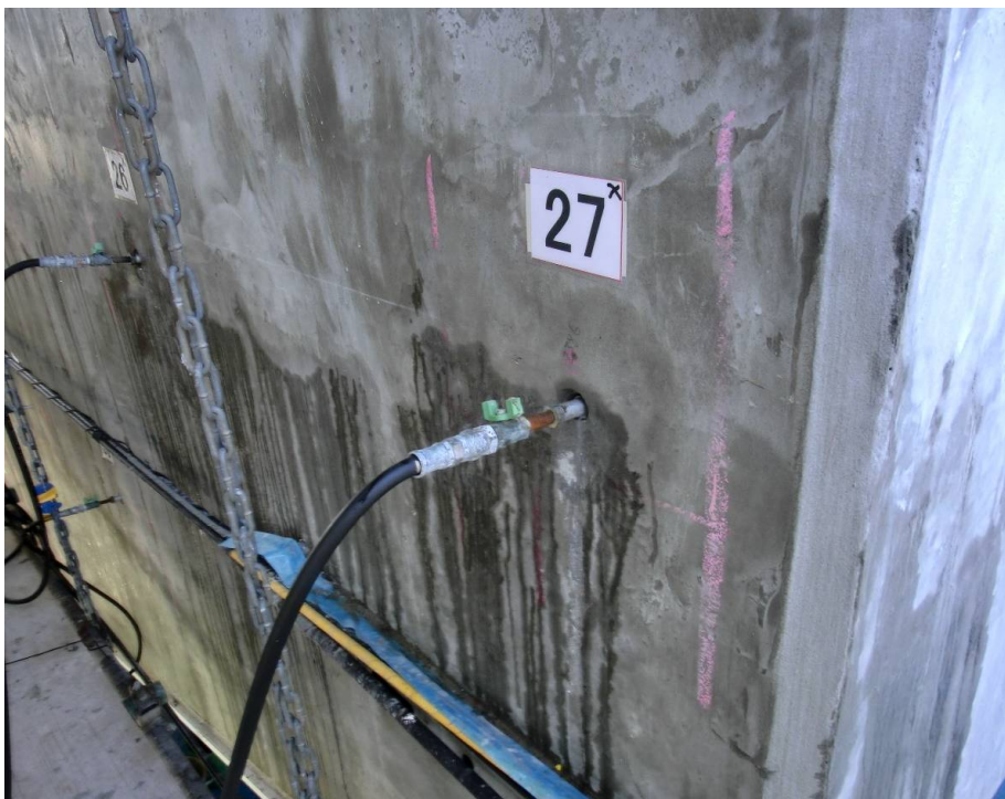
⑦試験加圧注入工
