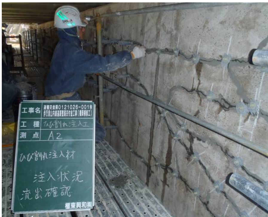
①表面漏出防止(ひび割れ注入)
