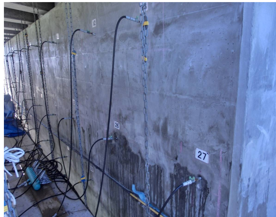
⑧本加圧注入工
