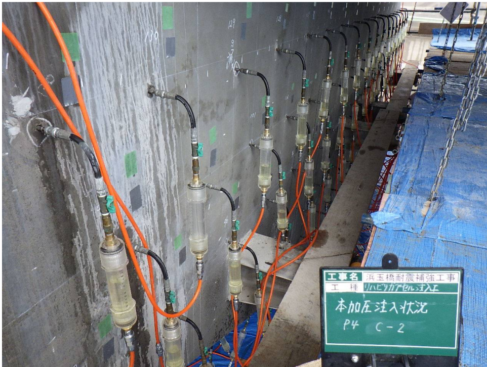
⑦本注入工
