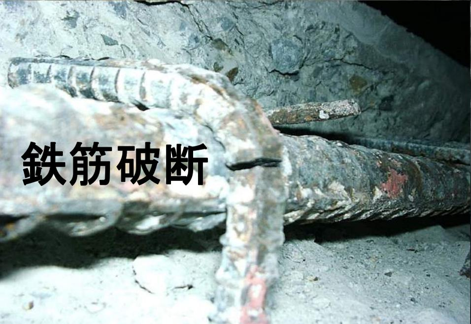
**鉄筋破断**
