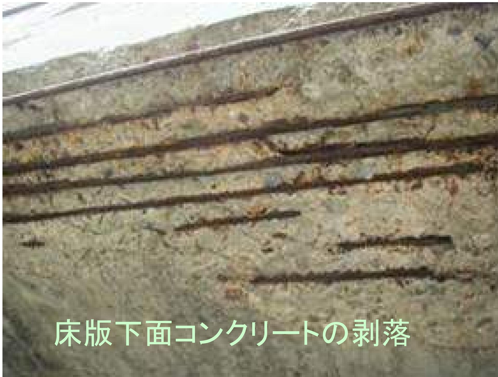
床版下面コンクリートの剥落
